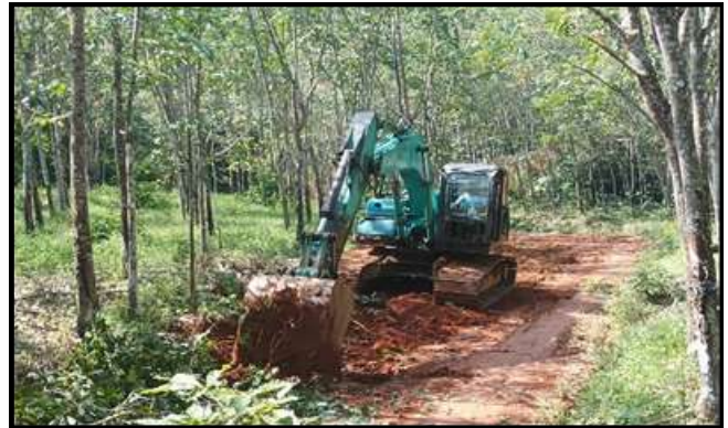
Ket : Bantuan Excavator, Perbaikan dan Pelebaran Jalan Akses Kebun Masyarakat Desa Mulya Sari - Lampung
