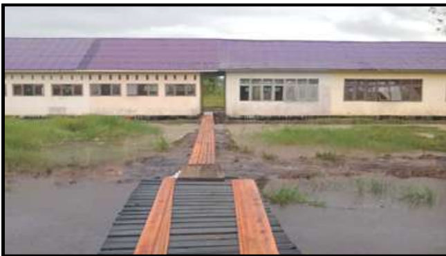
Ket ; Bantuan Pembuatan Jembatan Untuk Jalan Akses Sekolah SDN 18 Terentang - Kalimantan Barat
